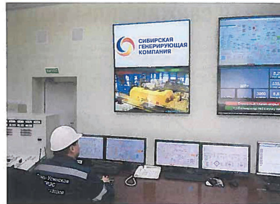
Энергоблок №5 Томь-Усинской ГРЭС готов к пуску
