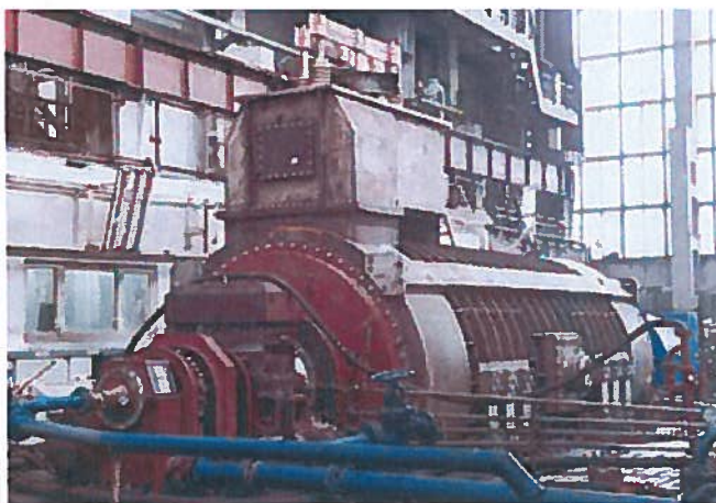
Турбогенератор ТВМ-500 по праву считается уникальным: он обладает рядом технических преимуществ по сравнению с другими аналогами, прост и надежен в эксплуатации
