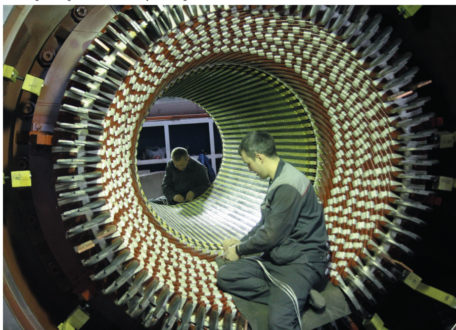
Укладка обмотки, бандажировка лобовых частей турбогенератора ТВФ-120 в условиях теплостанции
